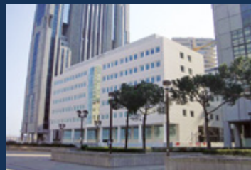
Complesso didattico del Centro Direzionale
